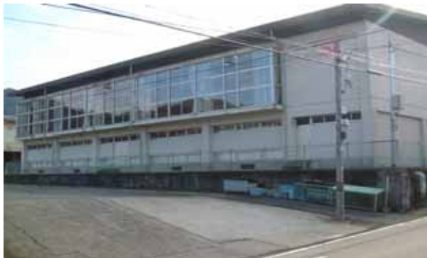
粟鹿小学校体育館
