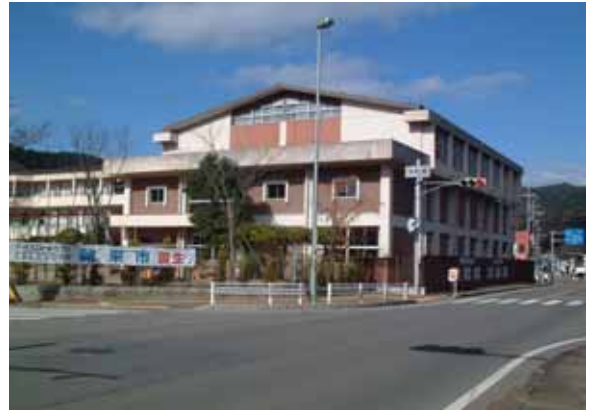
梁瀬小学校体育館
