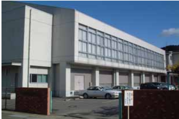
梁瀬中学校体育館
